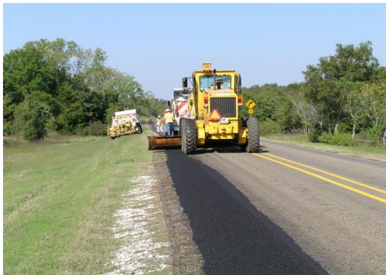
Figure 17. Edge Repair.
