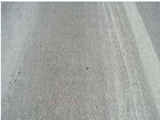
Fig. C.3.6 Longitudinal cracks
