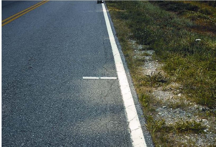
Figure 10 - Edge Cracking
