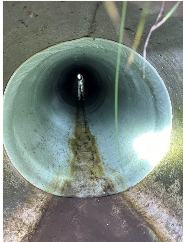
(d) Culvert 2184508, District 6: CIPP Liner
