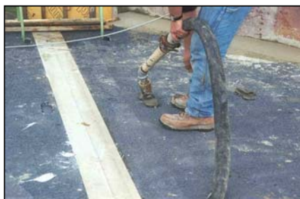
(d) Non-shrink grouting
