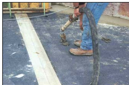
(d) Non-shrink grouting
