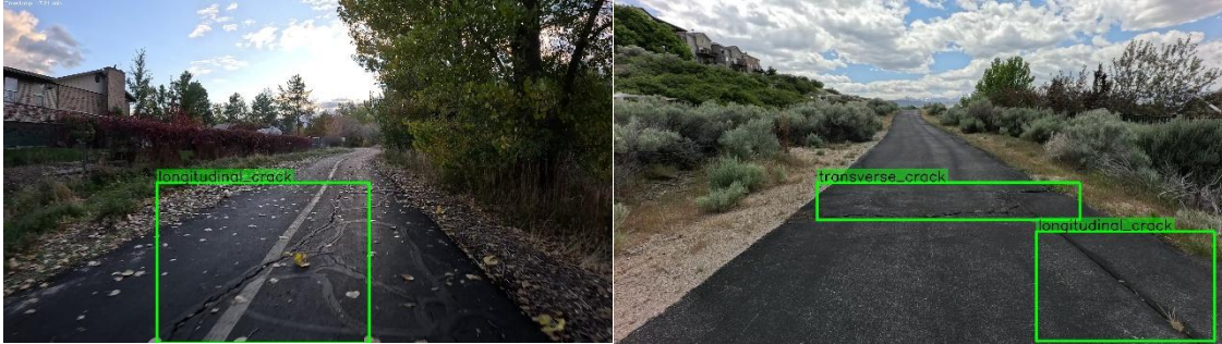
Figure C- 1: Longitudinal Crack
