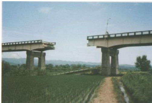
Falling Gerber girder
