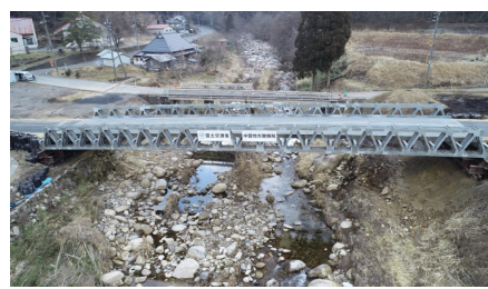
応急組立橋 (組立式下路ポニーワーレントラス橋)
