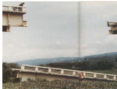
Falling Gerber girder
