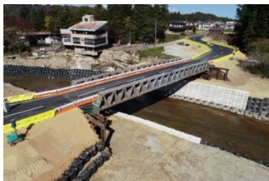
応急組立橋 (下路式ワーレントラス橋)
