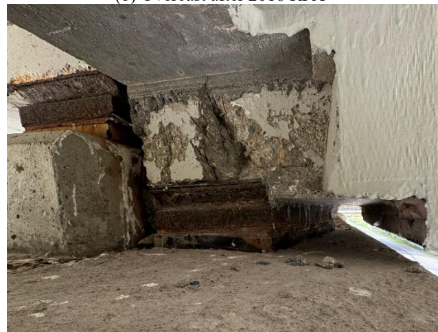
(d) Deteriorated beam end over the bearing
