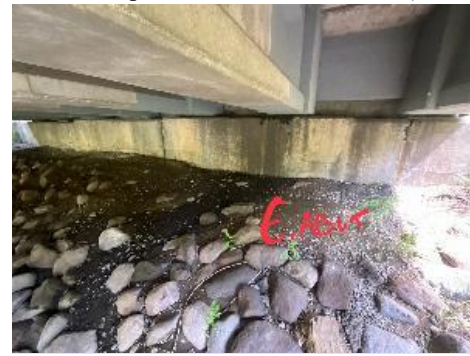
(d) Beam end repair at the east abutment (STR 3811)
