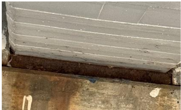
(d) Bearing plate condition
