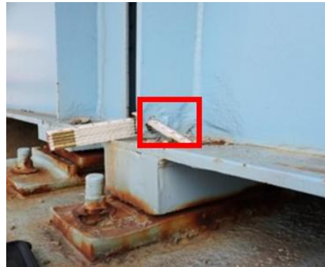
(d) Stiffener section loss at the bottom flange
