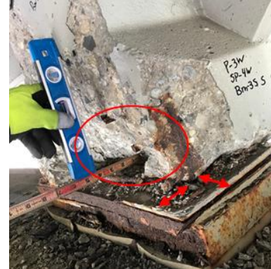
(d) Severe spall
