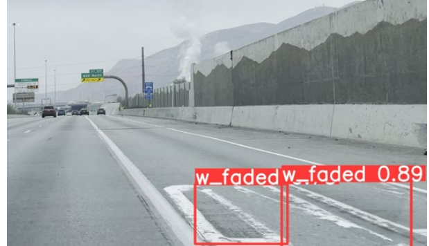
(d) Faded White Word Marking-2
