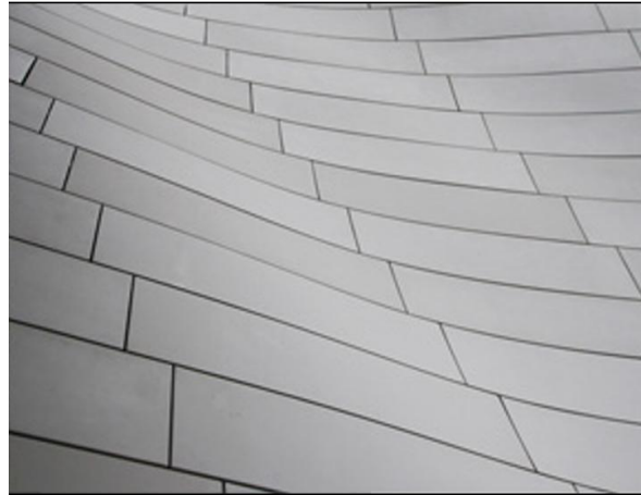
Figure 7.7. UHPFRC cladding, the “Iceberg” at Fondation Louis Vuitton pour la Création, Paris, France (designed by Gehry Partners)
