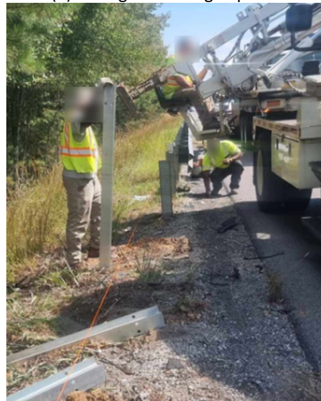
(d) Installing new posts
