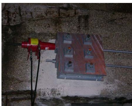
Fig. 17. Posttensioning the longitudinal rods
