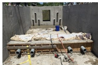
(d) Casting of the deviator
