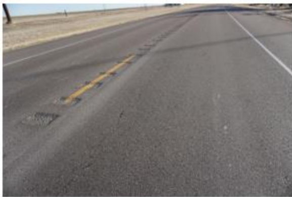
Longitudinal Cracking: 03/07/2017
