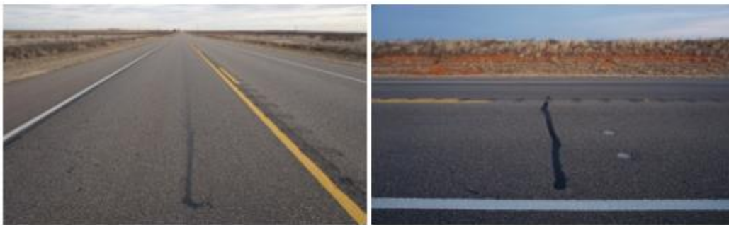
Longitudinal Cracking: 01/10/2018
