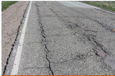
Longitudinal crack
