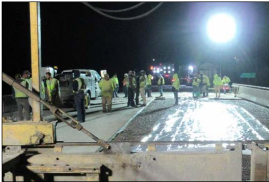
(a) Preparation for second pour
