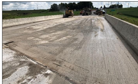
(d) Deck surface after completion of milling
