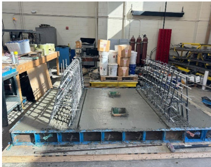
Figure 3.5 Concrete pour (deck)
