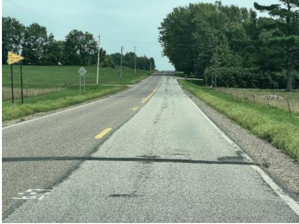
(g) Fibermat® chip seal CSAH-8
