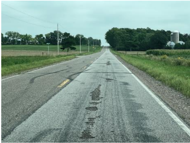
(c) Double chip seal CSAH-8
