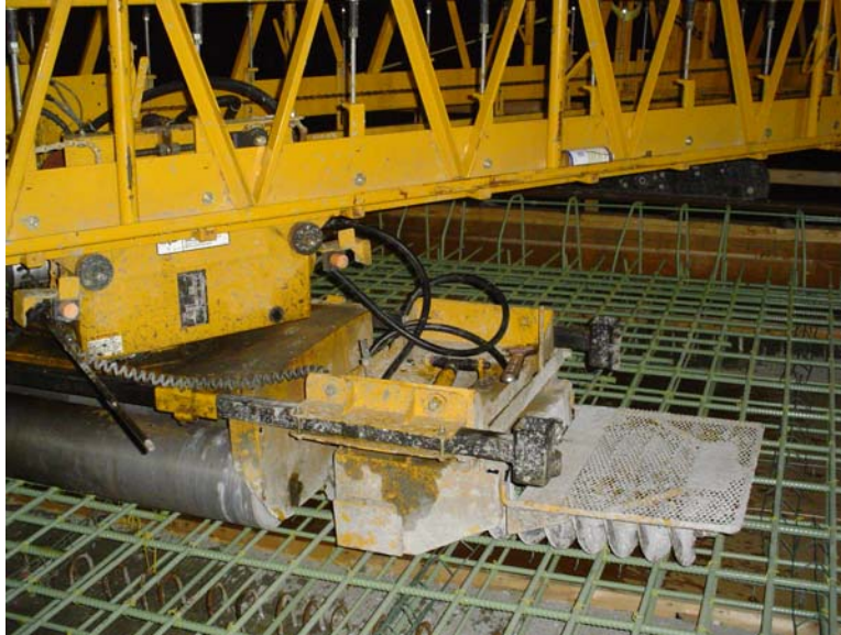
Fig. 8.20 Augur Set Up for the Second Concrete Pour
