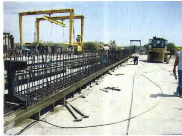
(d) Installation of Shear Reinforcement
