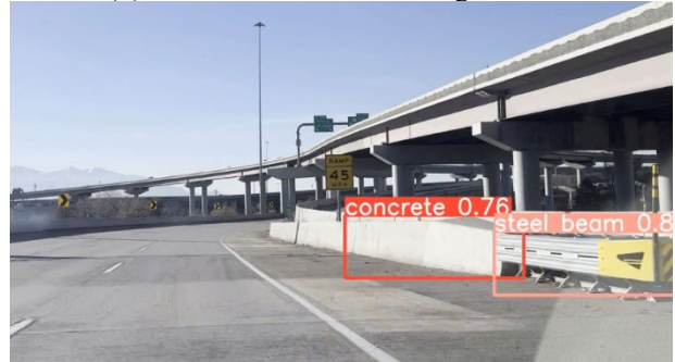
(d) Concrete barrier and steel guardrail
