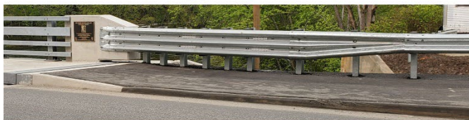
(d) 4-Bar to Buttress AGT
