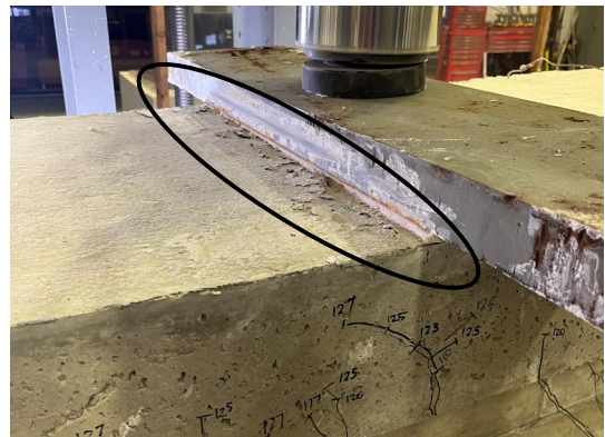
(d) Initiation of concrete crushing
