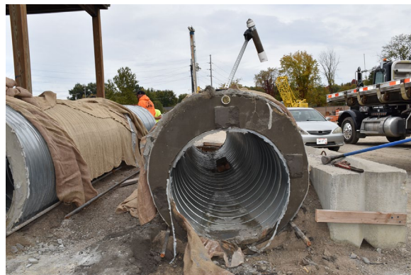
(d) CLSM Mix A5 at outlet
