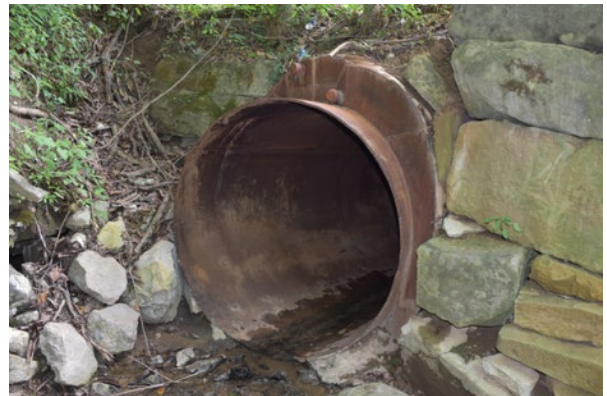
(d) Steel Casing Pipe
