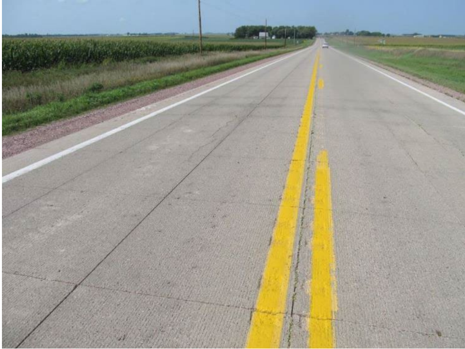
Longitudinal cracking
