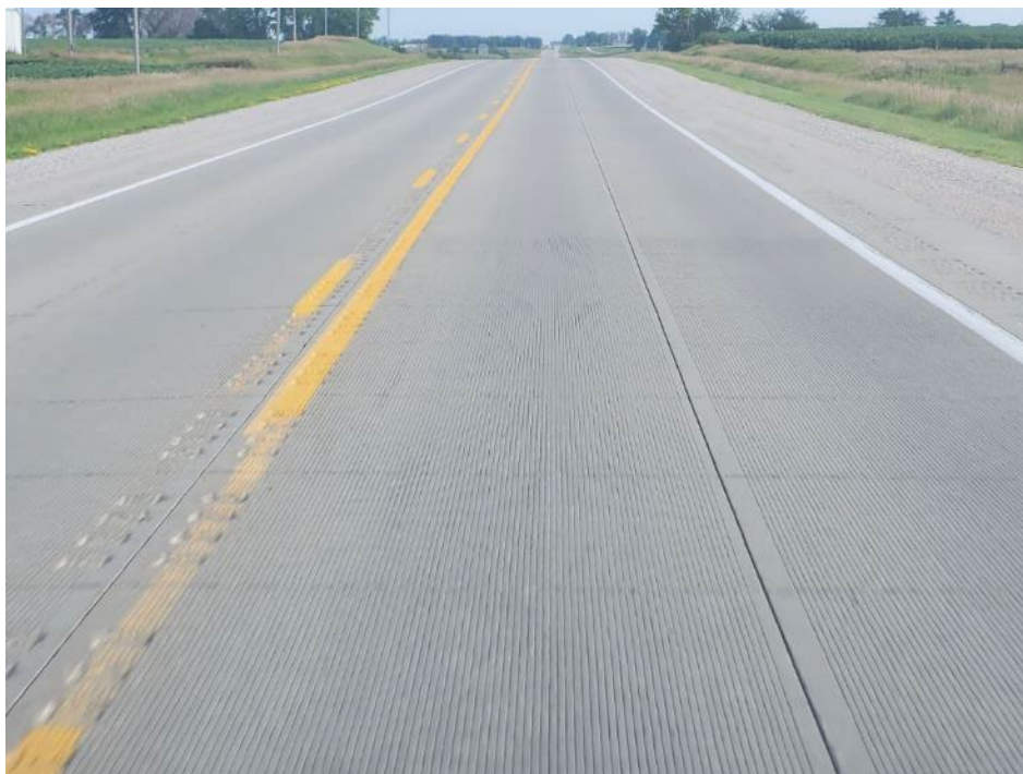
Whitetopping Overlay section
