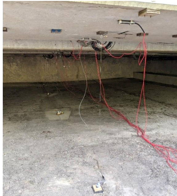
(d) String Pots at Midspan
