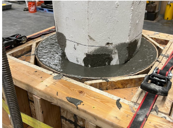
Figure 3.38 Precast 1 Completed Pour
