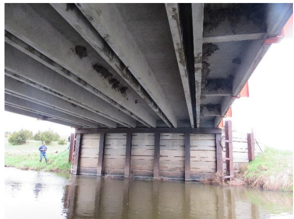
(d) Underneath of bridge
