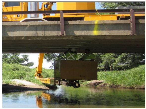
(d) Field Work Using Snooper Truck
