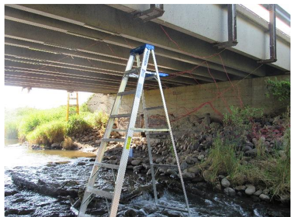
(d) Bridge Underneath View
