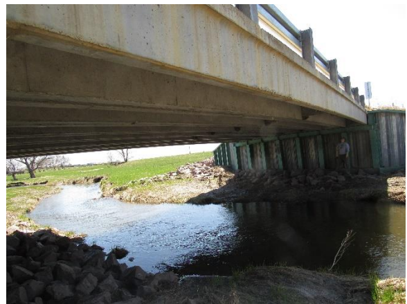
(d) Underneath of bridge
