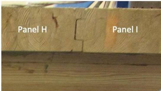
(d) Panel H-to-I Connection (West Side) at 0 Cycles
