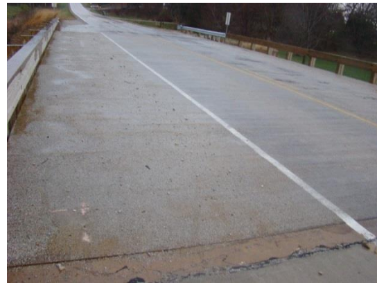
(d) Epoxy with Embedded Grit
