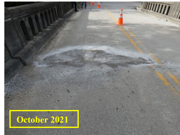
(d) Class I sand spread over epoxy
