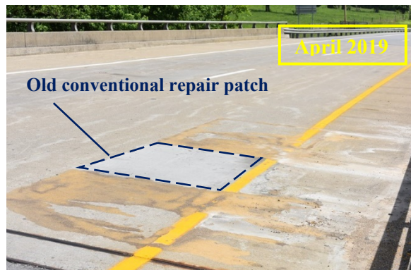
(d) Sand spread over the epoxy
