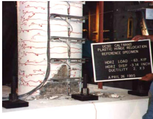
(d) Level III Damage
