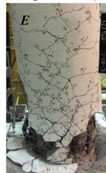
(d) CIP40: failure (8% drift)
