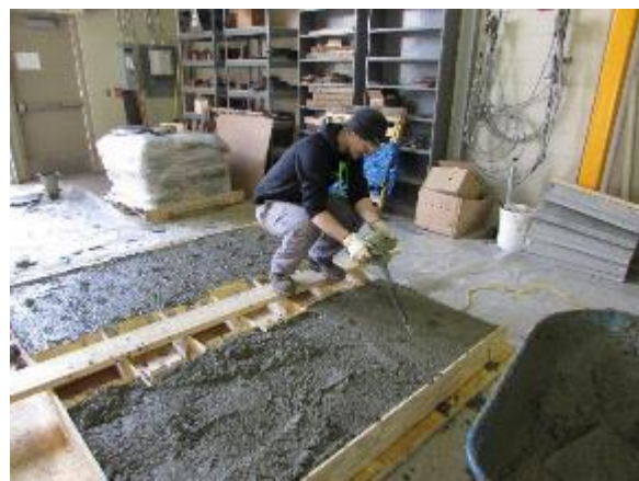
b. Pouring Concrete
