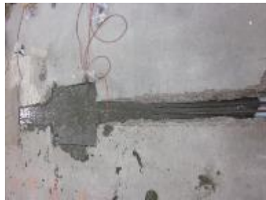
e. Pouring UHPC
