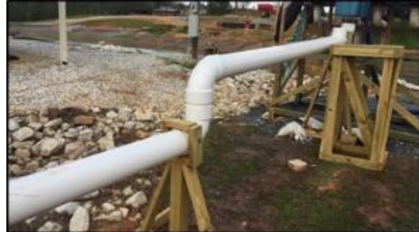
(d) flow conveyance and transition point
