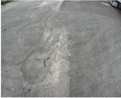
7.3. Edge Cracking
