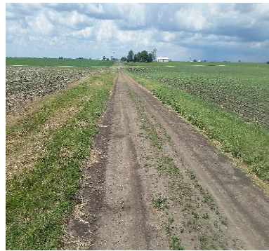
(d) Dirt road
