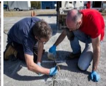
(d) Pouring epoxy
