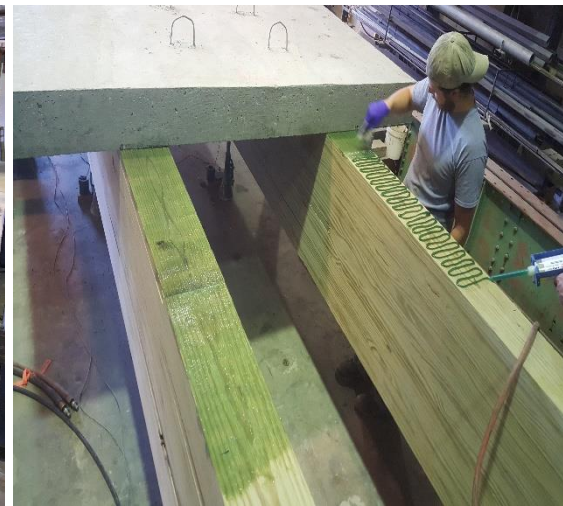
(d) Application of epoxy for precast panels
