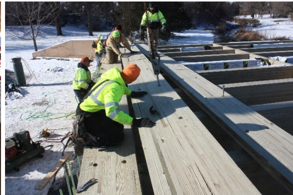
(d) Placing second deck panel
