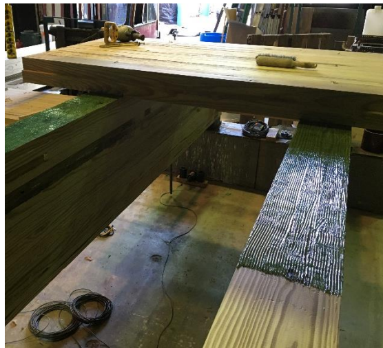
(d) Deck placement on epoxied girder
