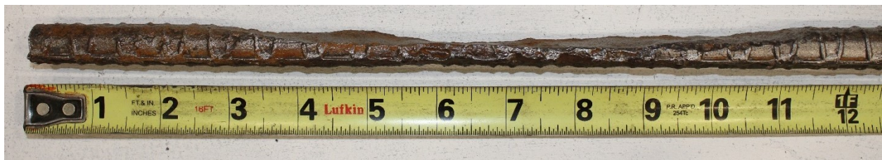
(d) S4 sample, #5 bar (30% section loss)
