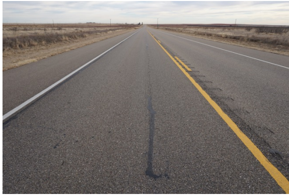
Longitudinal Cracking: 01/10/2018
