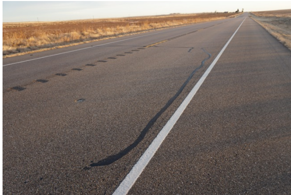
Longitudinal Cracking: 01/10/2018
