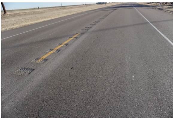
Longitudinal Cracking: 03/07/2017
