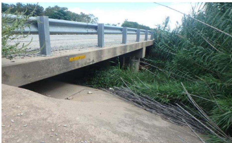
Figure C.9. Bridge CS-5 (TxDOT 2018c)
