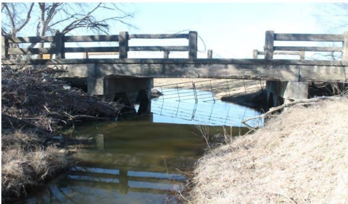
Figure C.5. Bridge CS-3 (TxDOT 2018c)
