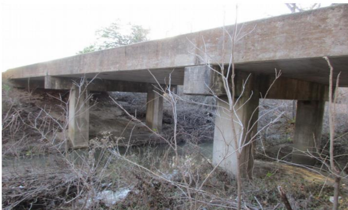
Figure 7.5. Bridge CS-9 (TxDOT 2018c)
