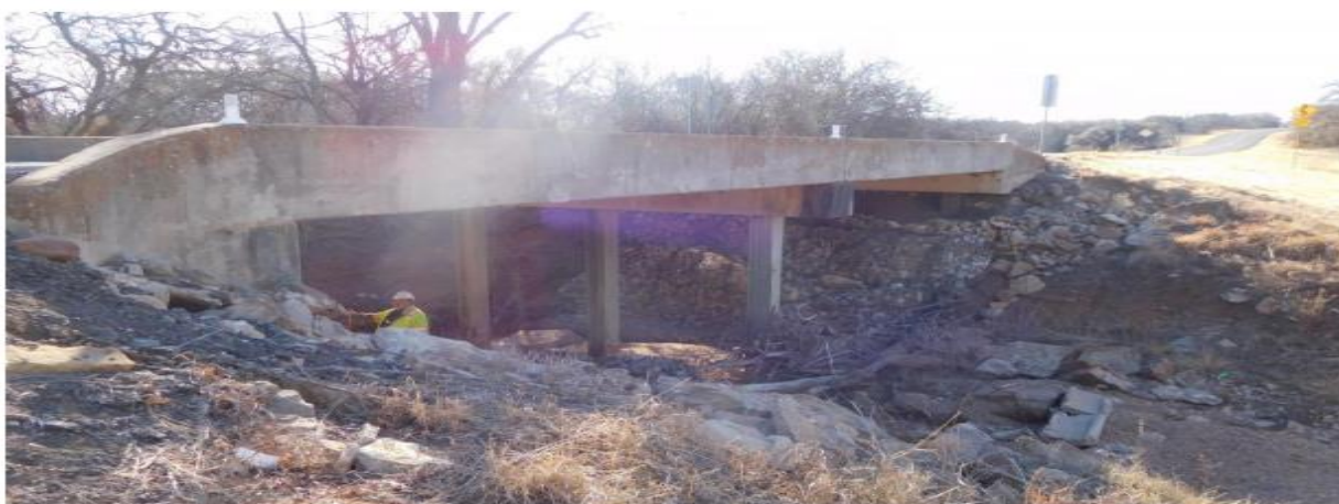
Figure C.25. Bridge CS-13 (TxDOT 2018c)
