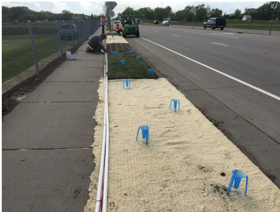
Figure 4.1 Larpenteur Avenue installation.
