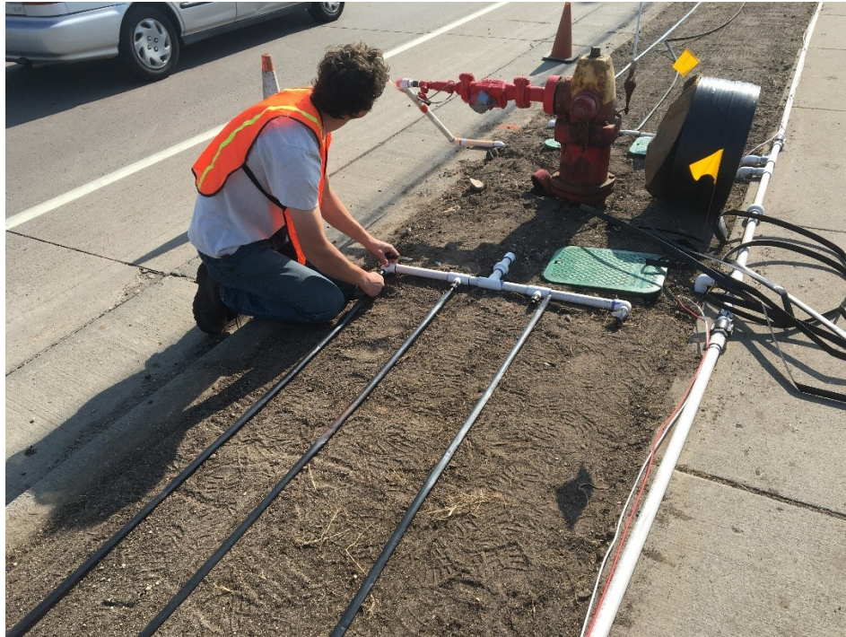
Figure 4.2 Larpenteur Avenue installation.
