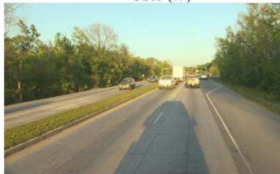
(d) UTW section on US90 after 10.2 years of service
