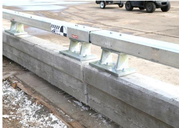
(d) Field side of bridge rail
