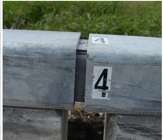
(d) Traffic side of metal rail at joint 4
