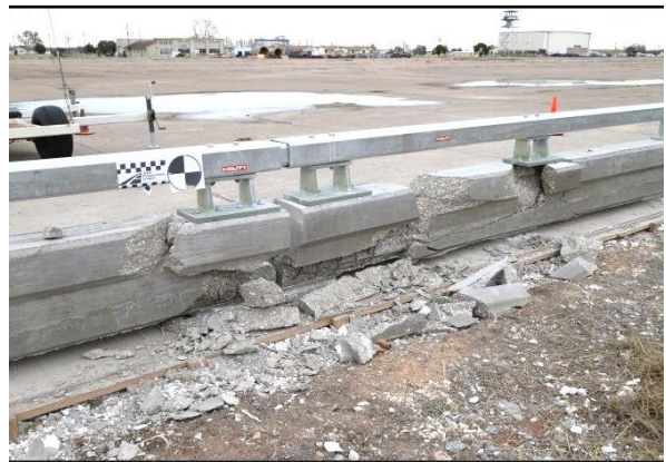
(d) Field side of bridge rail
