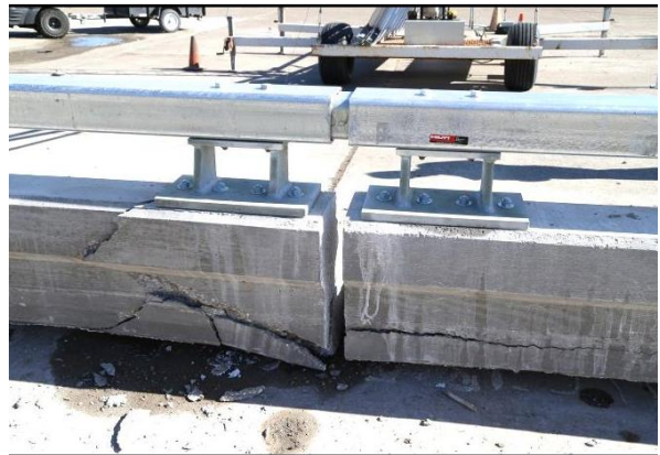
(d) Field side of joint
