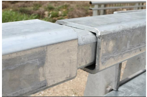
(d) Metal joint and sleeve
