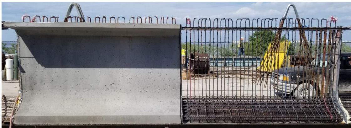
Figure 3-11 G1 before UHPC pour
