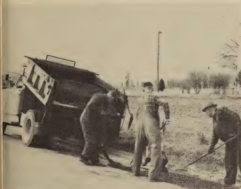
Filling shoulder edge rut
