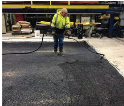
(d) Tack coat application
