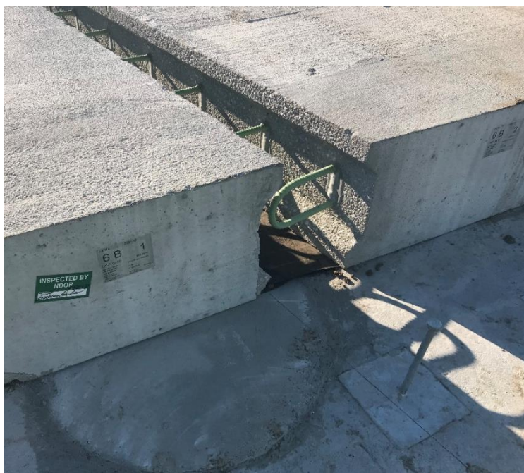
Longitudinal Joints
