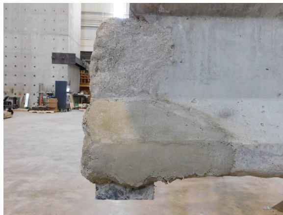
(d) Specimen After Mortar Repair
