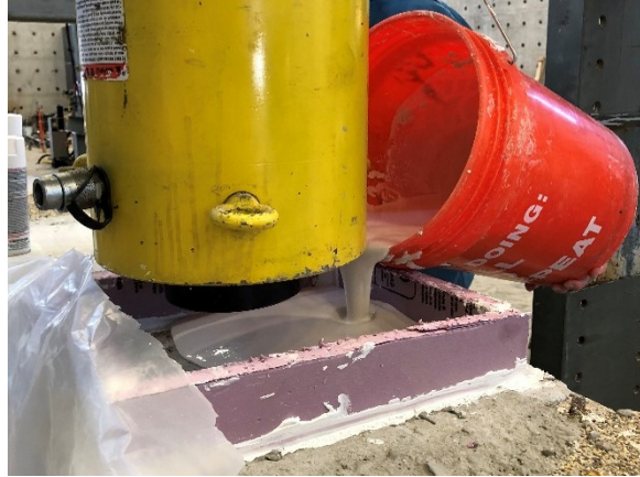
(b) Pouring Gypsum Concrete
