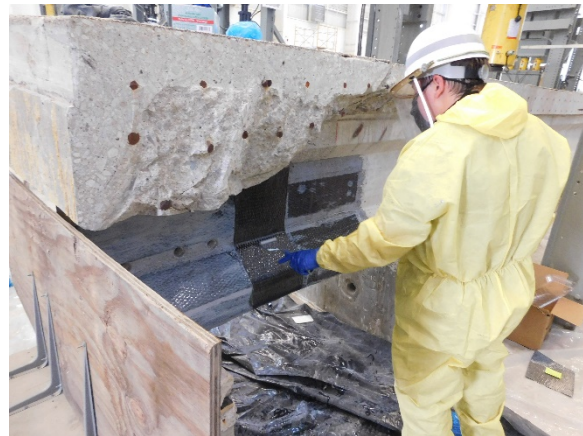
(d) Rolling FRP to Eliminate Air Pockets
