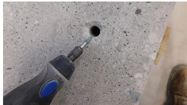
(d) Rounding Edges of Anchor Holes
