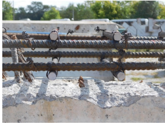
(d) Transverse Reinforcement
