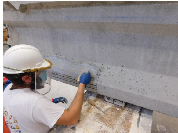
(d) Leveling Off Excess Epoxy Grout
