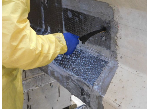
(d) Removing Wooden Dowel
