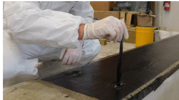
(d) Inserting Anchor
