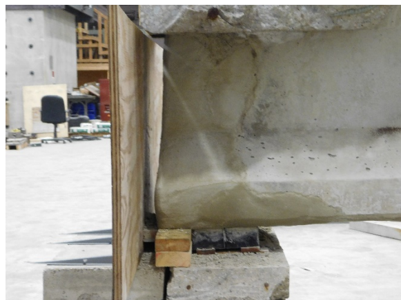
(d) Specimen After Mortar Repair
