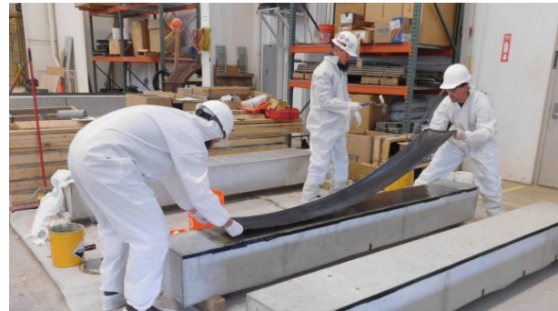
(d) Placing FRP Sheet
