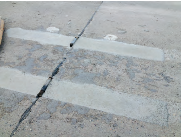
Dowel Bar Retrofit.
