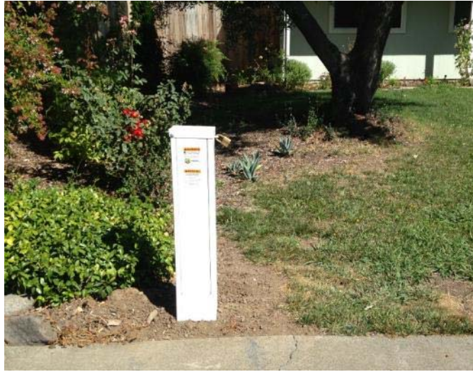
Figure 20. Rectifier Instrument Box
