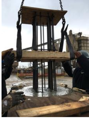
(d) Placement of dowel bars
